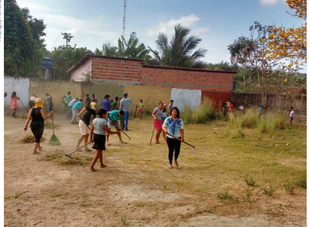
Mutirão de limpeza do espaço da escola onde será construída a praça. Povoado Vila União, Buriticupu - MA
